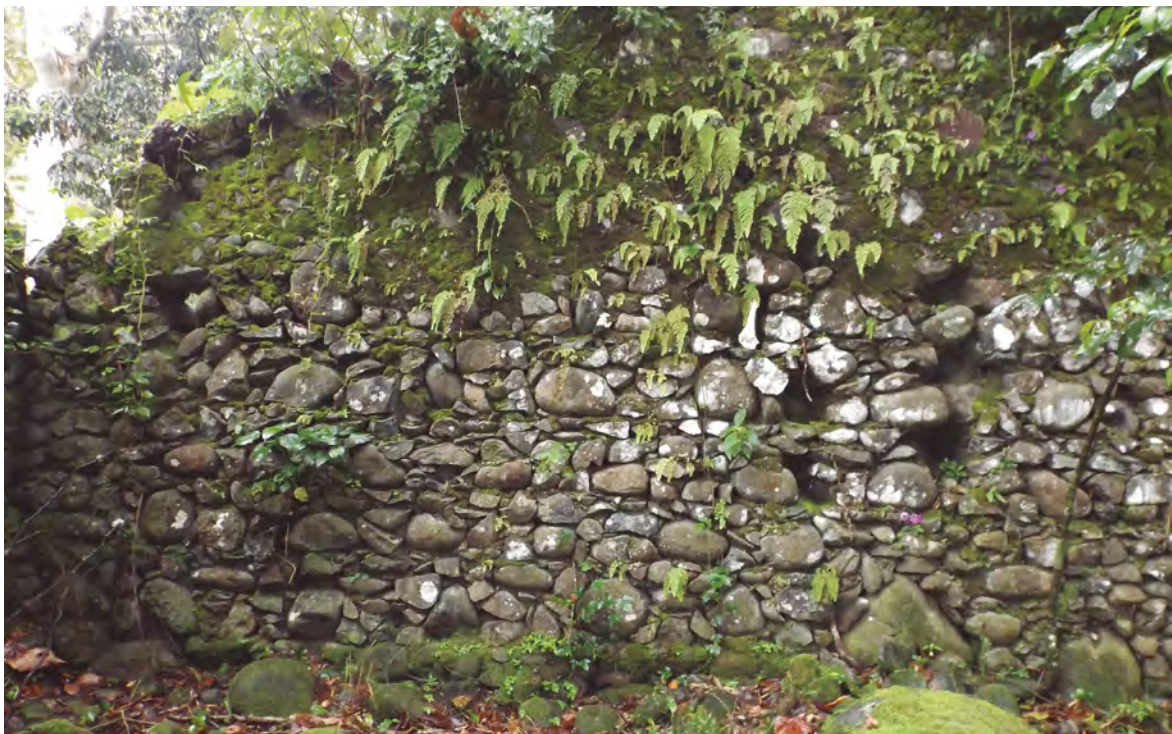
Imagen 16. Muros de mampostería cerca del río Metlac
