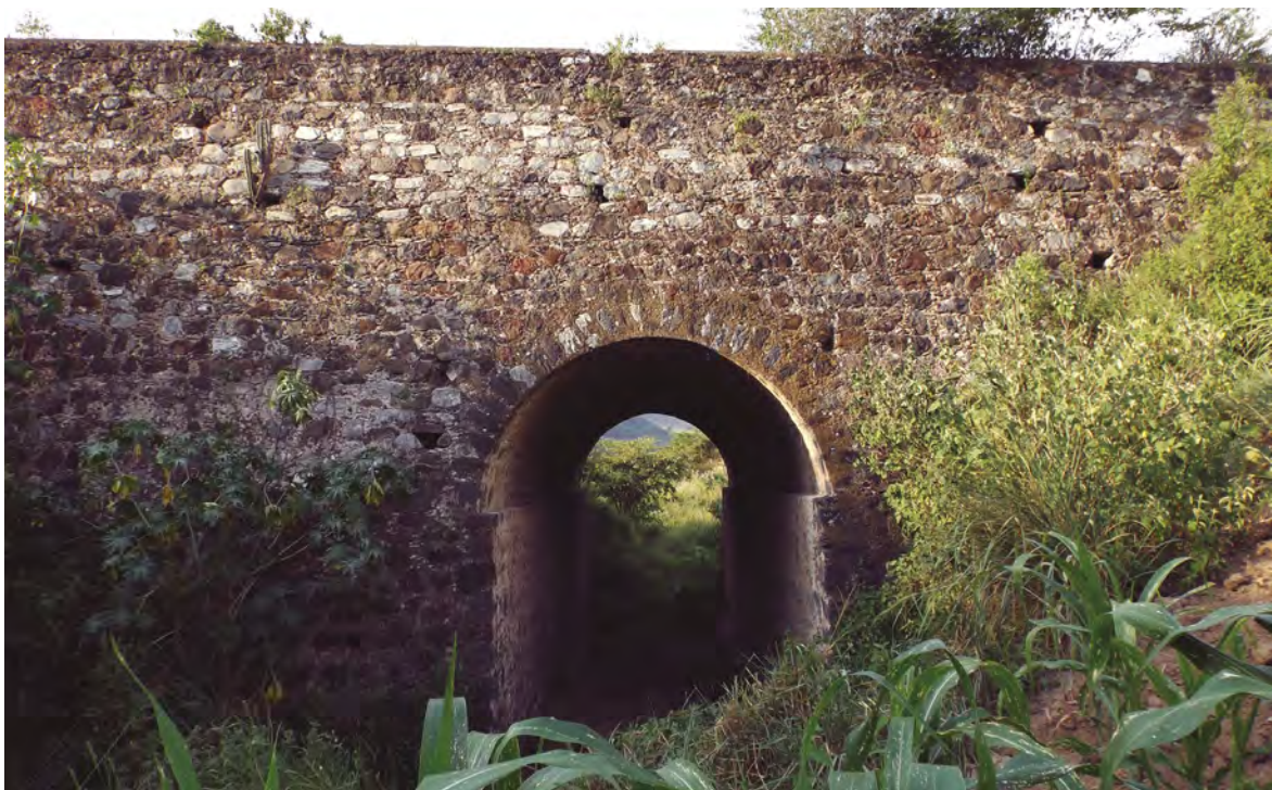
Imagen 17. El Puente Negro
