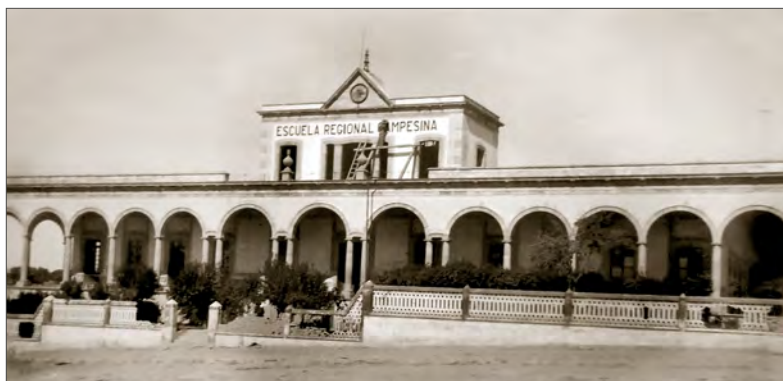
Trabajos de pintura realizados por alumnos de segundo año al Edificio Escolar.
