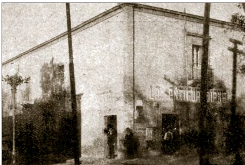
Primer edificio que ocupó la Escuela Normal Rural de San Juan del Río, Querétaro del 1 de febrero al 30 de septiembre de 1926. En Las misiones culturales en 1927 , México, SEP, 1928, p. 309.
