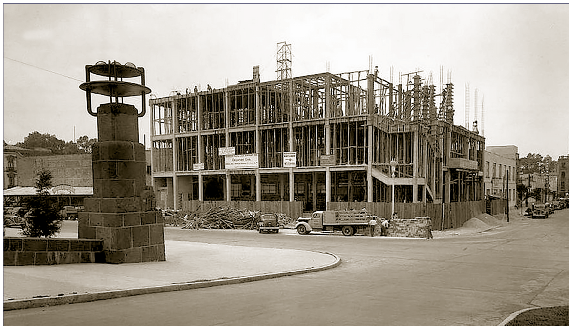
Imagen 44. Construcción del edificio de Plaza de la República 20, fotografía tomada el 21 de agosto de 1940.
