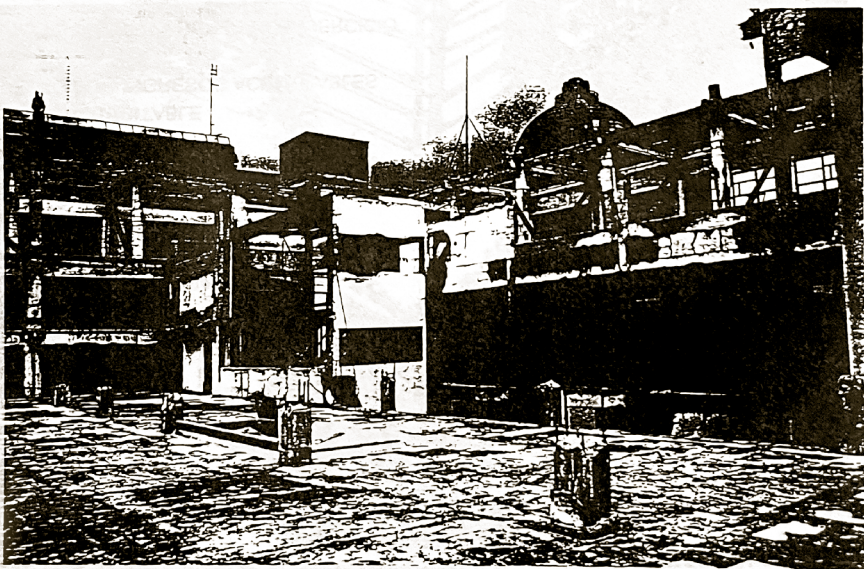
Foto 2 Vista general de la estructura del inmueble
