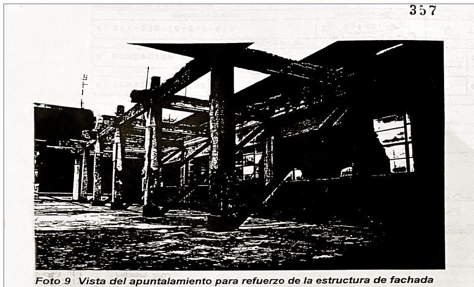
Foto 9 Vista del apuntalamiento para refuerzo de la estructura de fachada
