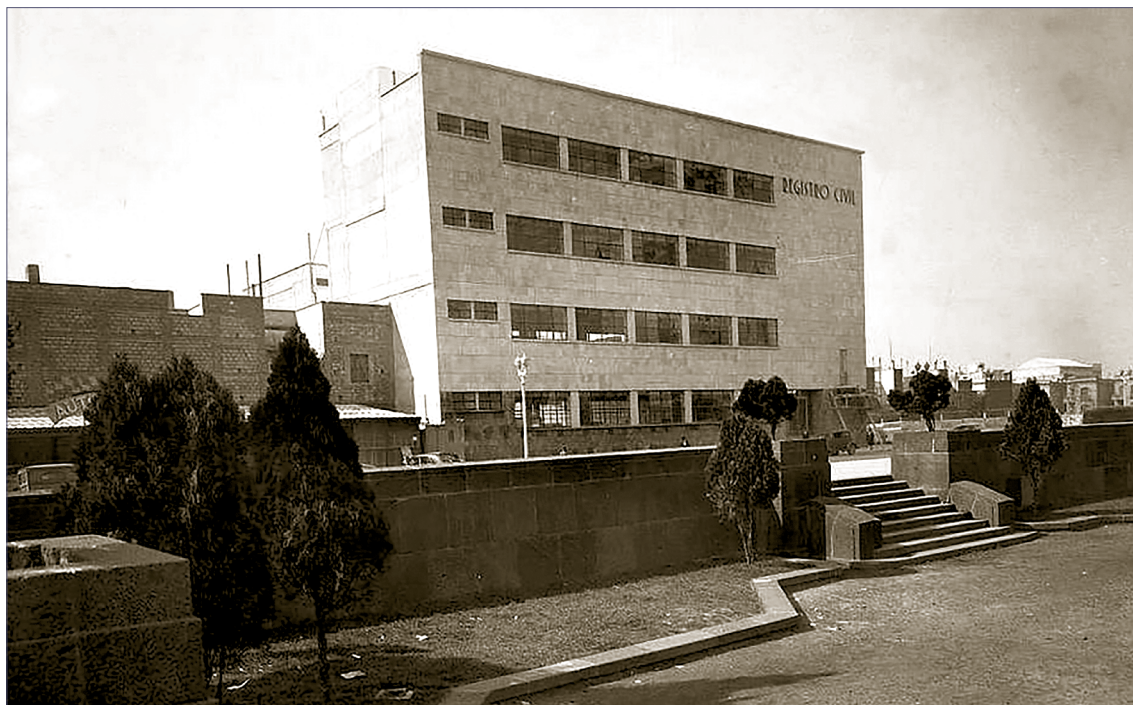
Imagen 45. Fotografía del edificio de Plaza de la República 20 tomada el 21 de febrero de 1941 cuando albergó el Registro Civil. Fuente: Museo Archivo de la Fotografía, registro 000441-001.
