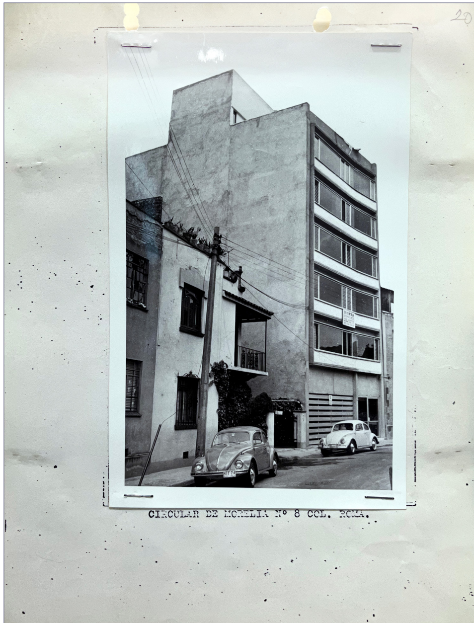
Imagen 17. Fotografía de perfil del edificio de Circular de Morelia núm. 8.
