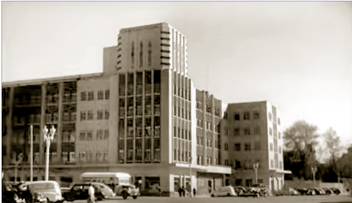
Imagen 1. Edificio de Av. de la República núm. 6, sede de la DFS, 1948. Consultada en video filmación. Fuente: Salvador Pruneda, Documental de la Dirección Federal de Seguridad (Dir. Salvador Pruneda), Dirección Federal de Seguridad, Distrito Federal, 1948, 37 m., disponible en: < https://www.youtube.com/watch?v=Q6TkIAX5ZE0 > (Consultado: 10/07/2024).
