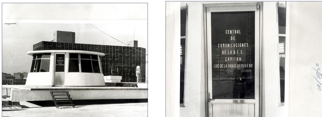
Imagen 51. Fotografía de la Central de Comunicaciones de la DFS instalada en la azotea del edificio de Plaza de la República 20. Fuente: AGN, Fondo Secretaría de Gobernación Siglo XX, Sección DFS, Exp. 009-005-007, Leg. 2, H. 15 y 19.
